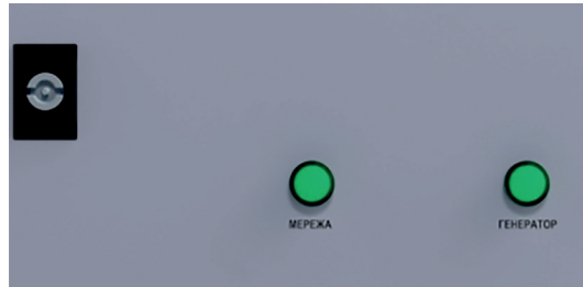
Рис. 5.2 – Сигнальні лампи "Мережа" (HL1) та "Генератор" (HL2)
